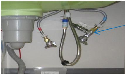
シンク下から分岐してチューブをシンク上部に取り出して接続する。(キッチン扉のすきまを利用するか6mmの穴を開けてチューブを通します)
